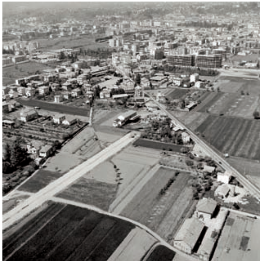
Via Candelo - Strada Trossi in costruzione, Biella, 1963
