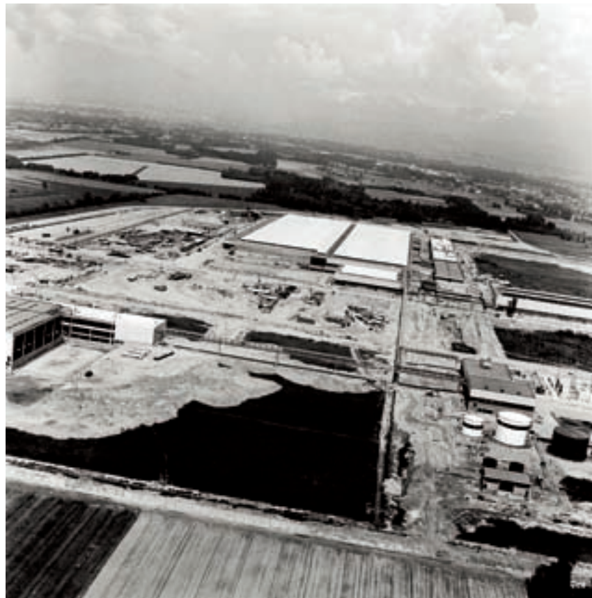
La costruzione dello stabilimento Lancia, Verrone, 1974
